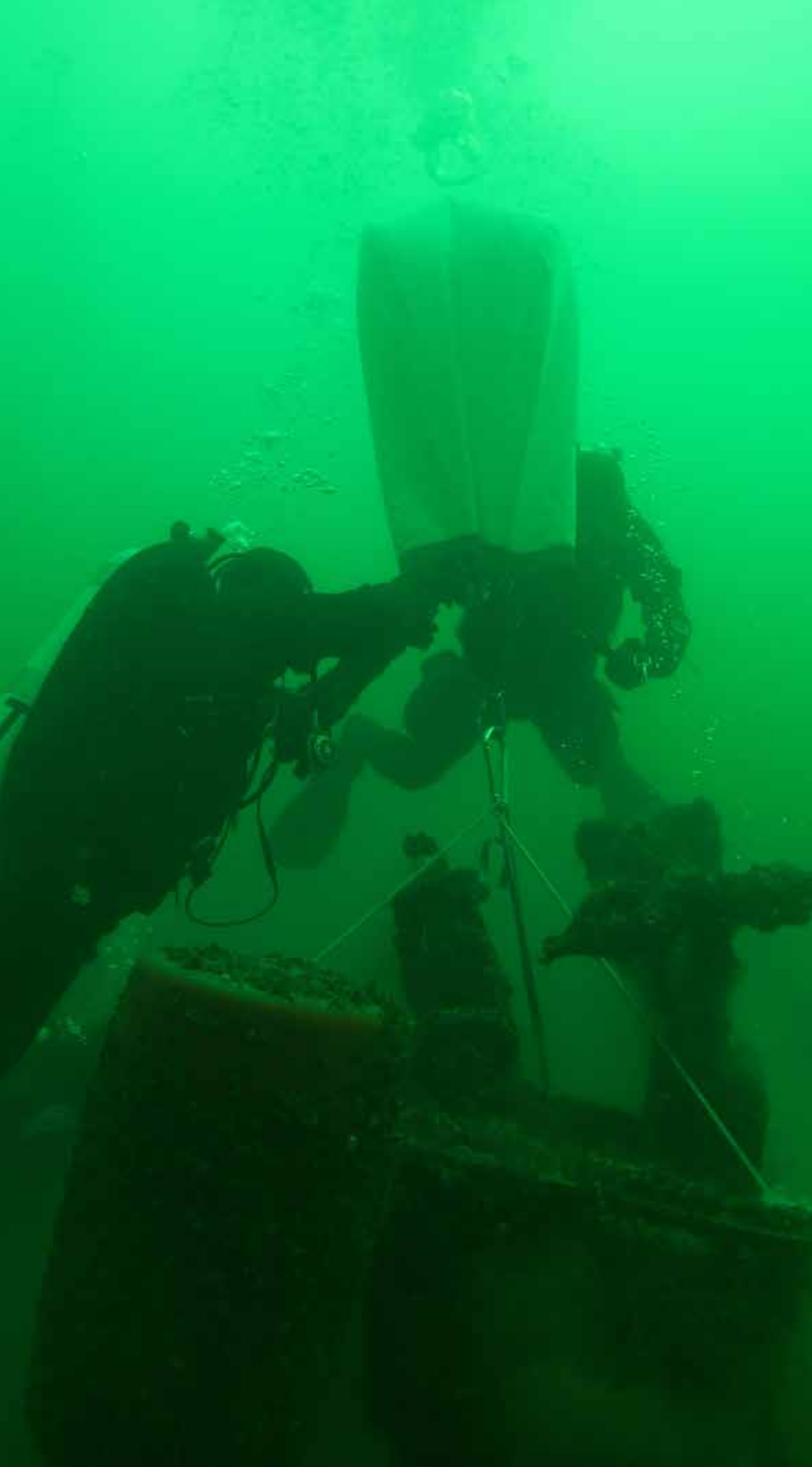
Hebesäcke und selbstlose Landhelfer erleichtern die Arbeiten.
